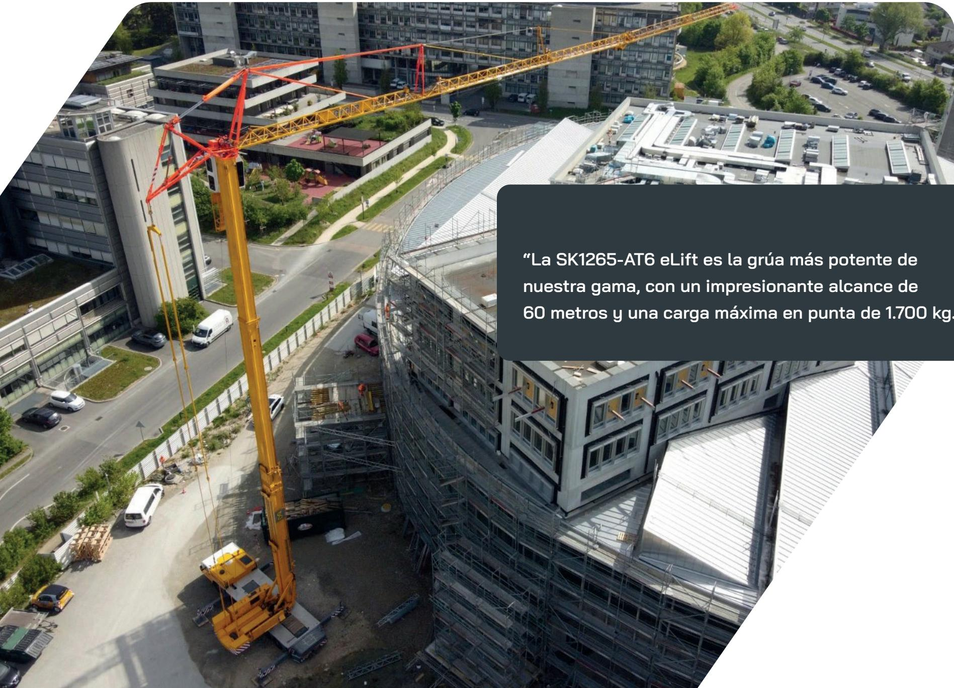
“La SK1265-AT6 eLift es la grúa más potente de nuestra gama, con un impresionante alcance de 60 metros y una carga máxima en punta de 1.700 kg.”
